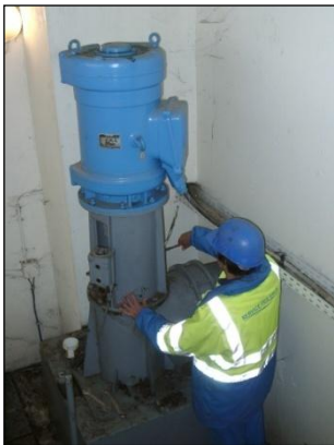
Figure 6 Intervention sur une pompe de refoulement
